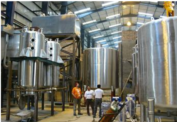
Planta Azúcar Líquido San José de Abajo en construcción
